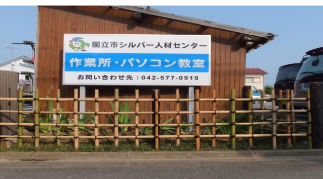
四ツ目垣完成で周りが綺麗になった作業所
